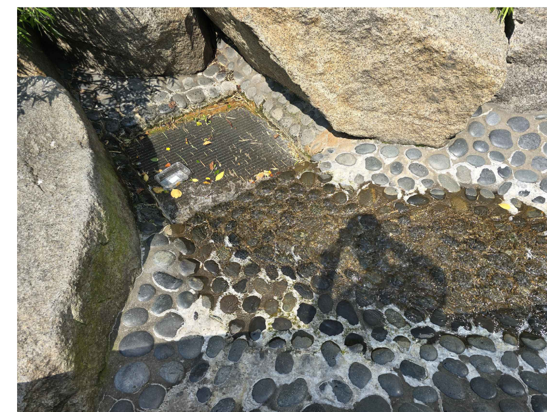
4 EXISTING RIVERBED DRAIN CONDITIONS SCALE: N.T.S.
