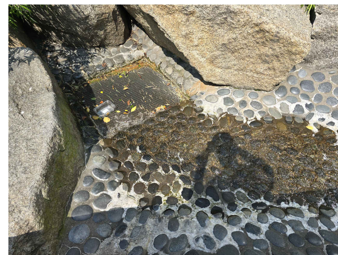
4 EXISTING RIVERBED DRAIN CONDITIONS SCALE: N.T.S.
