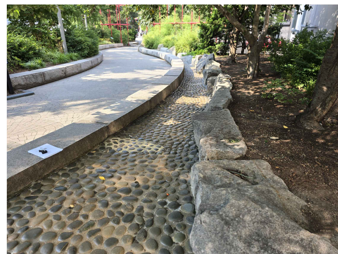
3 EXISTING RIVERBED CONDITIONS SCALE: N.T.S.
